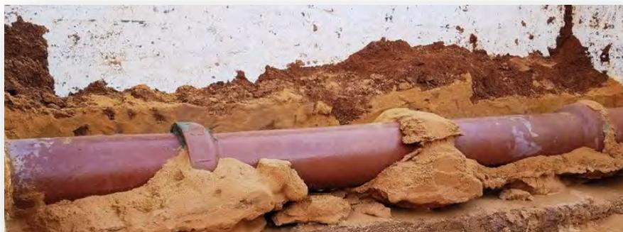
Exhumation de la conduite colmatée afin de constater les masses de sol imbibées d'acrylamide entourant les défauts et montrant les réparations étanches qui stabilisent également les conduites.
